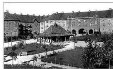
Trafoen ble i sin tid bygget i samme nyklassistiske stil som Torshov-kvartalet.
